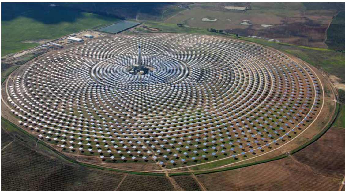
Vue satellite, le 20 /05/2021, du gigantesque parc solaire Noor à Ouarzazate
